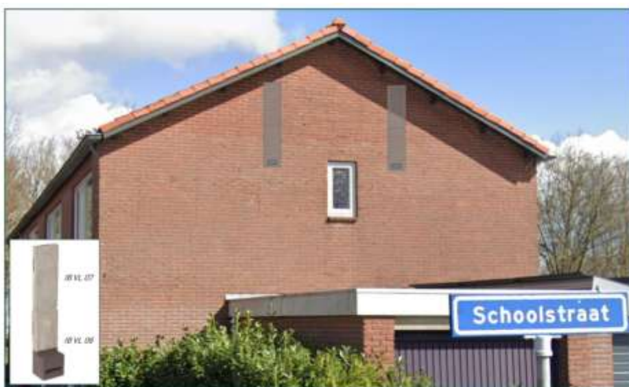
Figuur 2.5 Visuele weergave van de ingemetselde voorzieningen (type IB VL 06 met IB VL 07) voor vleermuizen aan Kloosterstraat 2.
