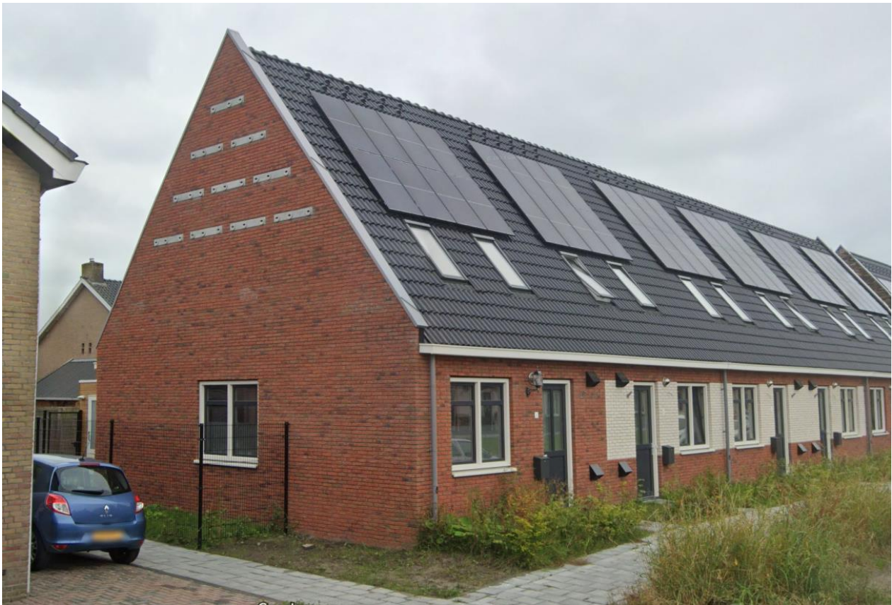
Figuur 2.3 Inbouwkasten voor gierwaluw en gierwaluwpennen in een van de nieuwbouwwoningen in fase 2.
