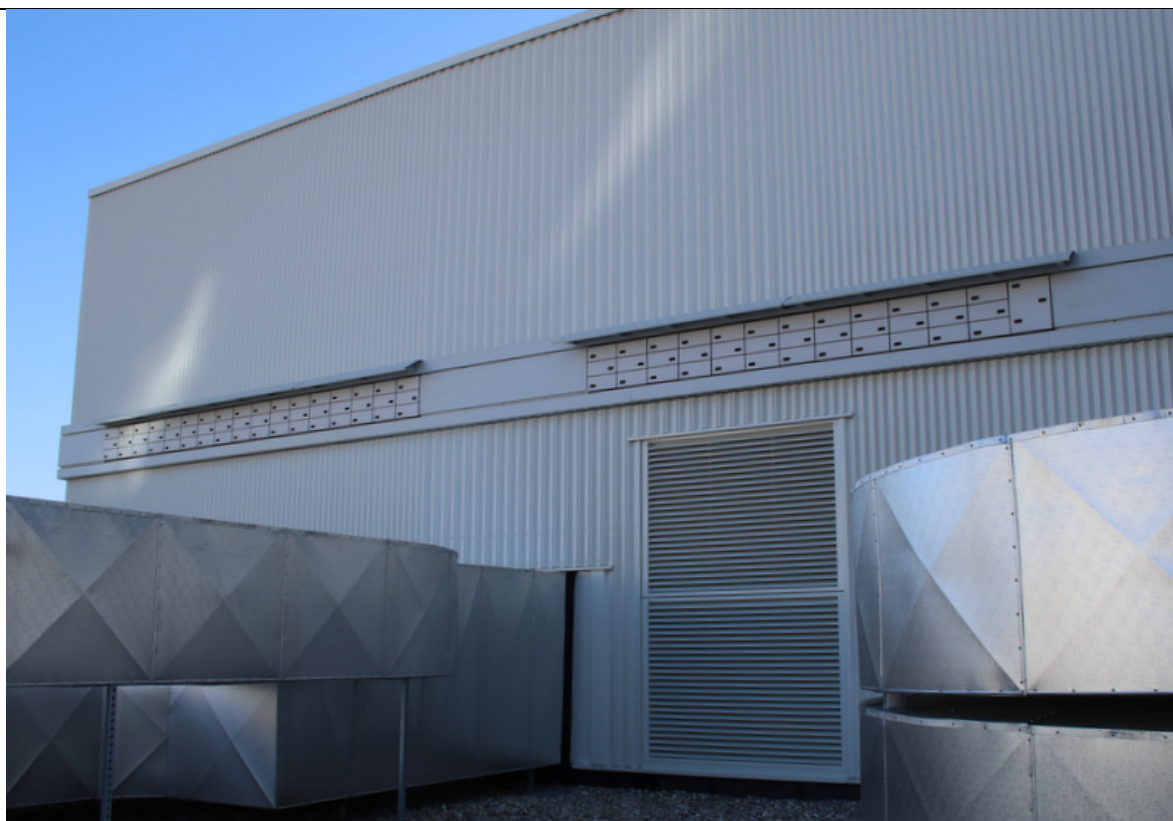
Foto 2. Gierzwaluwkasten aan de zuidwestzijde. Hier zijn luifels geplaatst.
