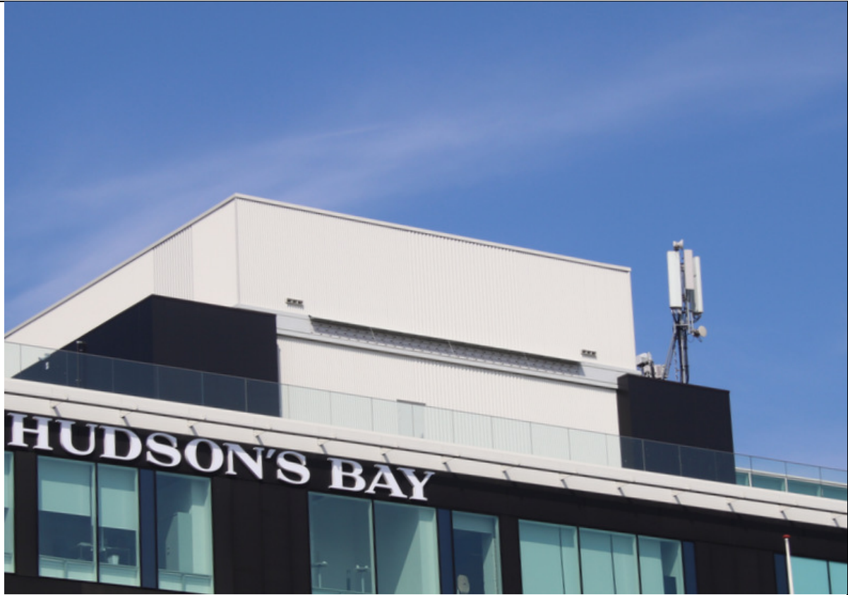
Foto 4 Overzicht gierzwaluwkasten aan de zuidoostzijde.
