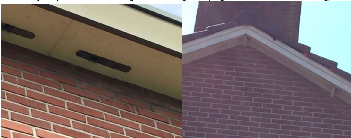
Afbeelding 40: Toegankelijk boeiboorden in Spaanskamp en oplichten pannen voor gierzwaluw in de Norden (met uitvliegende gierzwaluw).
