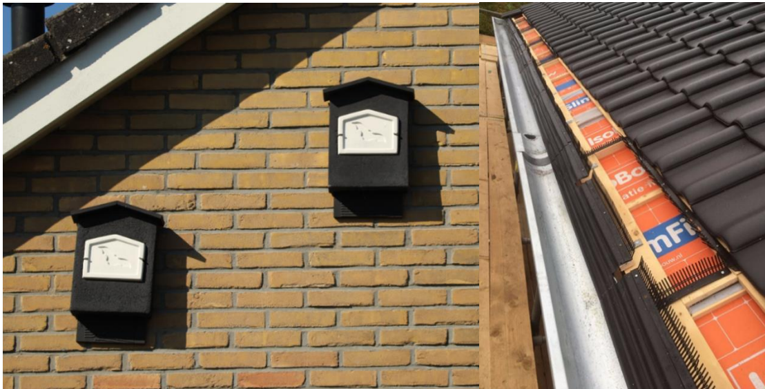
Afbeelding 41: geplaatste vleermuiskasten en huismusvoorzieningen (vogelvide) bij renovatieprojecten.
