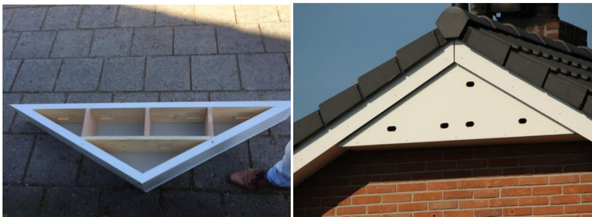
Afbeelding 38: Voorbeeld geplaatste Nokkasten
