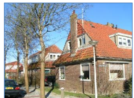
Schoorsteen op P. Feddestraat 17
