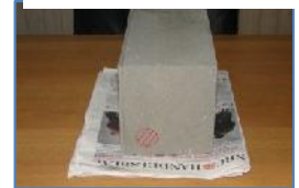
Positie gat in metselwerk
