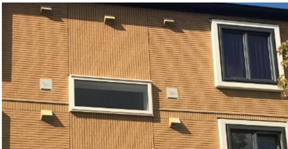
Afbeelding 21: Voorbeeld entreesteen en toegankelijke spouwmuur (bron Eelerwoude en mitigatiecatalogus)
