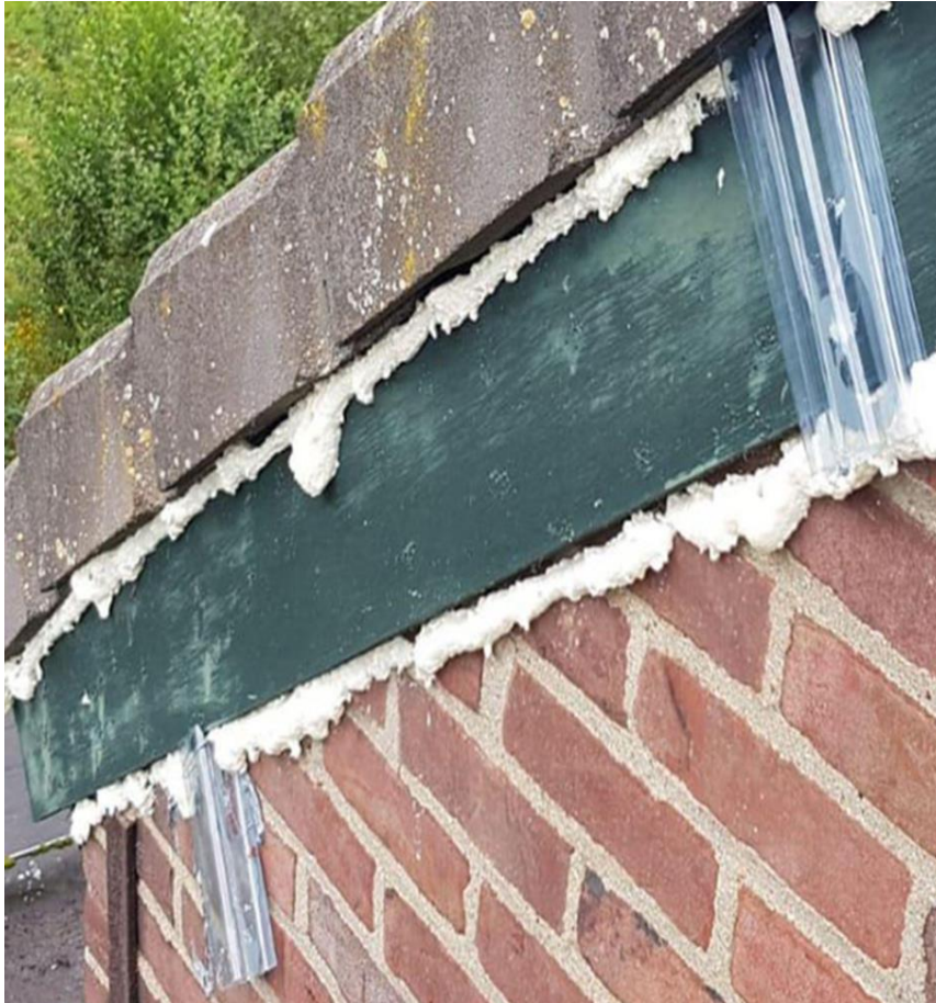
Afbeelding 9: Voorbeeld van het toepassen van exclusion-flaps voor vleermuizen, waarbij overige uitgangen dichtgemaakt zijn (bron: Faunaprojecten.nl).
