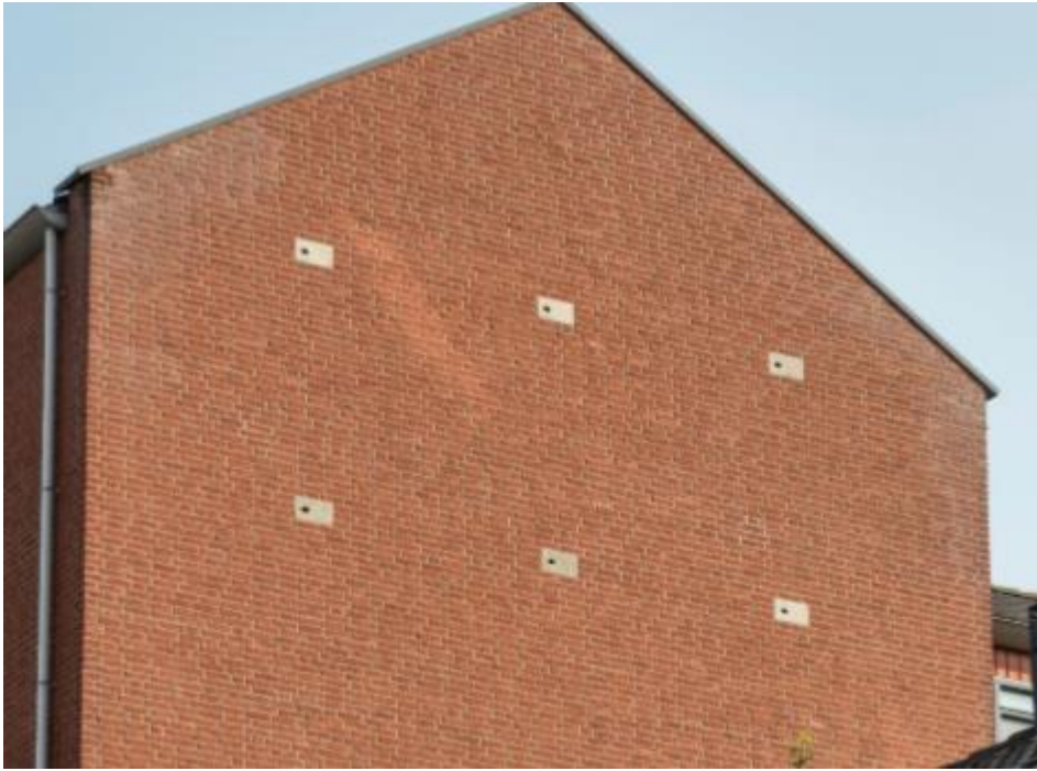
Afbeelding 13: Voorbeeld Inbouwkasten (bron mitigatiecatalogus)
