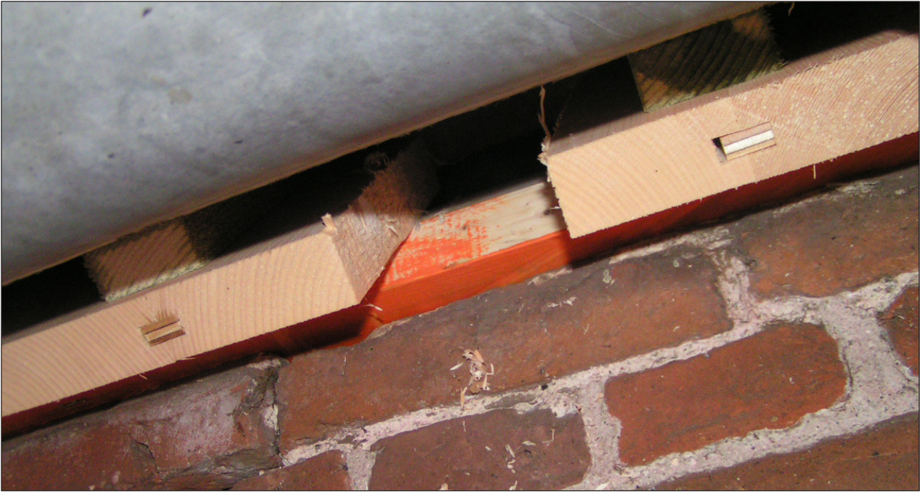
Figuur 4. Kerk Tjalleberd, december 2011. Nestingen, ontstaan door rotting van dakbeschot, zijn bij de vervanging behouden. Er wordt opnieuw op de (oranje) muurplaat gebroed (foto Jaap Langenbach).
